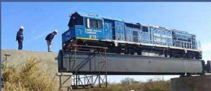
Estructuras metálicas pesadas
